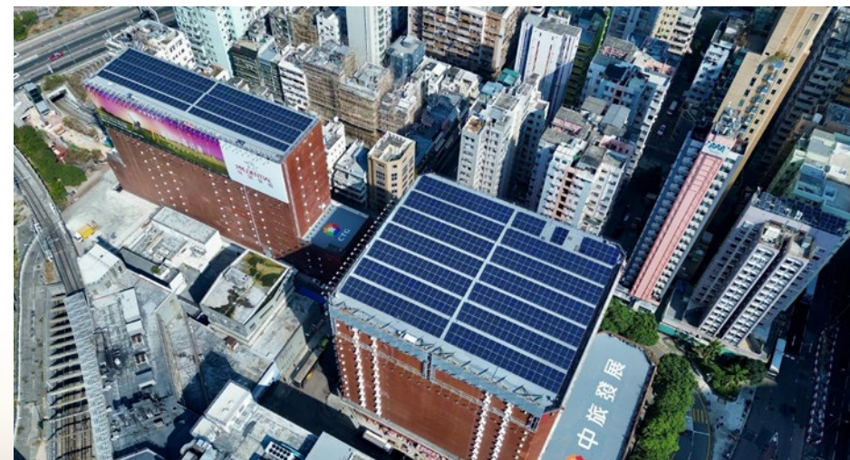
中旅发展在协记货仓建设分布式光伏装机容量约 541kWp，建成投产后年发电量约 65 万千瓦时，预计每年可减少二氧化碳排放量约 510 吨
