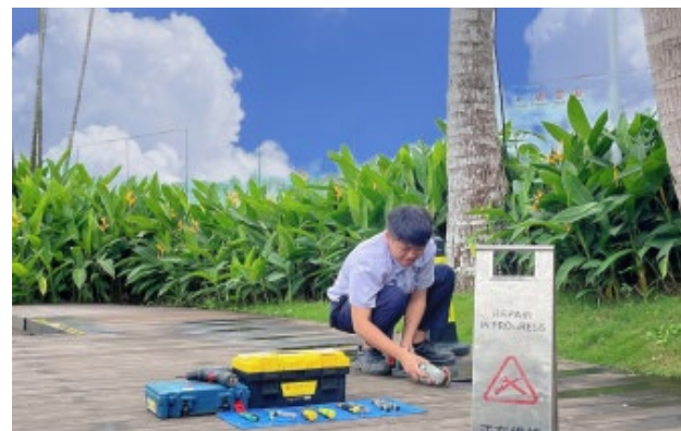
中旅物业海南公司开展户外木栈道维护
